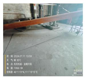
地下原料储存池与原料应急储罐输送管道
